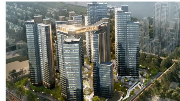
반포주공1단지(1,2,4주구) 주택재건축정비사업 • 소재지: 서울특별시 서초구 반포동 • 세대수: 5,335
