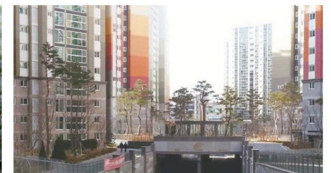
화곡3주구 재건축정비사업 • 소재지: 서울특별시 강서구 화곡동 • 세대수: 2,603
